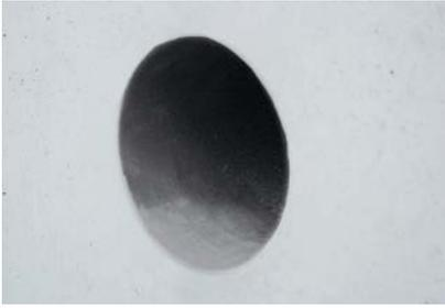
**1.** Kernbohrung mit Durchmesser 100 mm, 150 mm, 200 mm bzw. 300 mm herstellen. Toleranz  $-0/+2$  mm. Eventuell Nachbehandlung der Schnittfläche erforderlich. Pro Kernbohrung generell zwei Dichtelemente einbauen.
