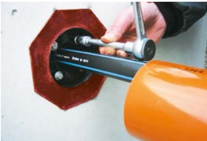
**4.** Schrauben in mehreren Durchgängen über Kreuz anziehen. Anzugsmoment 6 Nm.
