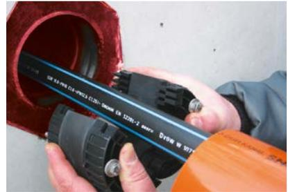
**3.** Dichtelement über die Mediumleitung klappen und bis zum Anschlag in das Lamellenrohr einschieben.
