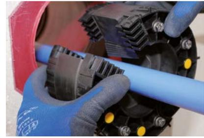
**3.** Dichtelement über die Mediumleitung klappen und bis zum Anschlag ins Lamellenrohr schieben. Alternativ dazu können beide Dichtelemente von innen eingebaut werden. Dazu die Anschlagnasen beim ersten Dichtelement abwickeln und ins Lamellenrohr schieben. Danach wie vorher beschrieben weiter vor gehen.
