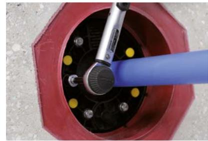
**6.** ... Schrauben mittels Drehmomentschlüssel auf 6 Nm anziehen.
