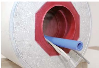
**1.** Mediumleitungen durch das einbetonierte Lamellenrohr schieben.
