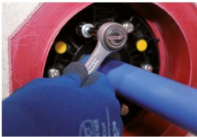
**4.** Schrauben in mehreren Durchgängen über Kreuz anziehen. Beginnen Sie bei den Schrauben am Teilungsmechanismus.
