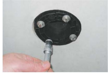
**3.** Schrauben in mehreren Durchgängen über Kreuz anziehen. Anzugsmoment 6 Nm.
