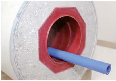
**1.** Mediumleitung durch das einbetonierte Lamellenrohr schieben.
