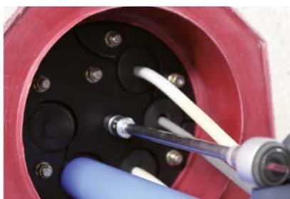
**4.** Schrauben in mehreren Durchgängen über Kreuz anziehen. Beginnen Sie mit den zwei Schrauben in der Mitte. Anschließend die Schrauben mit Drehmomentschlüssel auf 6 Nm anziehen.
