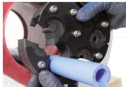
**3.** Dichtelement über die Mediumleitungen klappen und bis zur Anschlagkante ins Lamellenrohr schieben. Alternativ dazu können beide Dichtelemente von innen eingeschoben werden.
