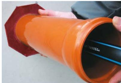
**5.** Setzungsschutzrohr in das Lamellenrohr einstecken.
